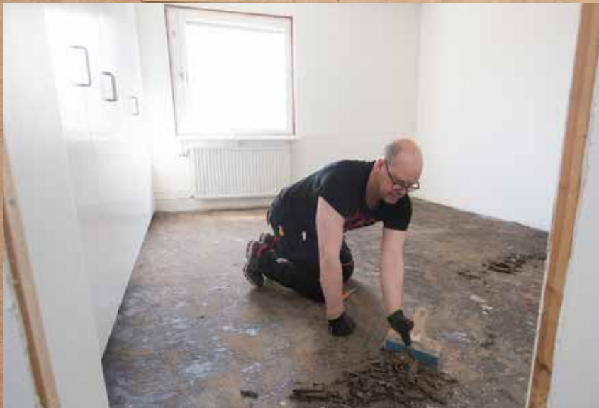
Snickaren Göte Rydberg skrapar bort resterna av det gamla golvet innan det nya läggs på plats. Steg för steg renoveras så lägenheten.
